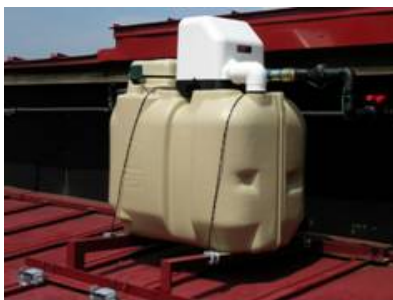
工場屋根への散水
